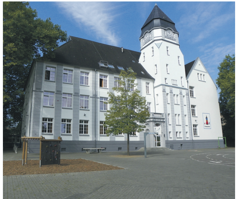
Bei der Turmschule wurde die unter anderem die Fassade komplett neu beschichtet.
