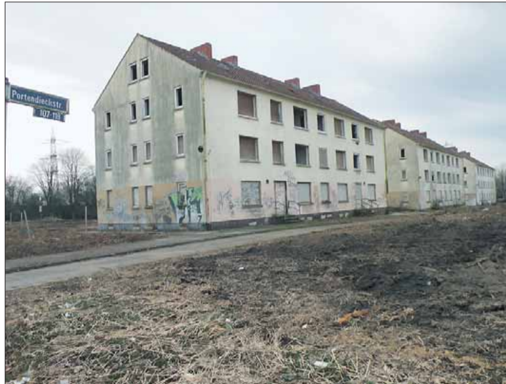
Gehören hoffentlich bald der Vergangenheit an, die Notunterkünfte an der Portendieckstraße/Ecke Garnbleiche/Landschede in Schonnebeck. Fotos: Willi Zimmermann
